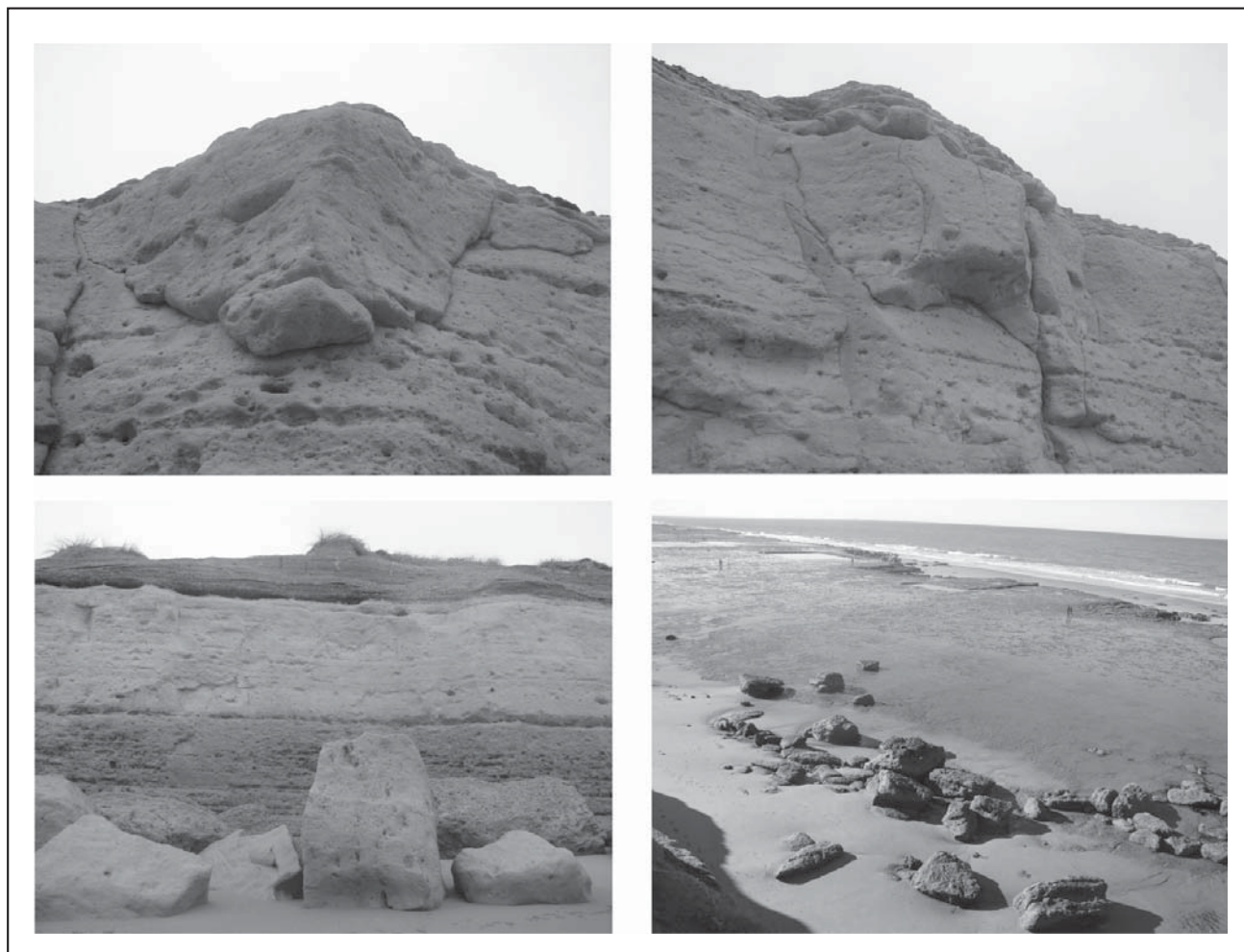
Figura 7. En la fotografía adjunta pueden observarse cómo dos bloques "colgados" se presentan con diaclasas paralelas al frente del acantilado y en las dos fotografías inferiores la presencia de bloques dispersos en la playa producto del desplome.
