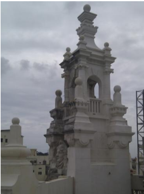
Figura 14- Pretil y torre de la esquina izquierda de la fachada este donde se muestra la parte interior restaurada y la exterior aun sin terminación.
