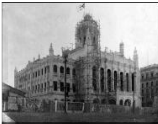
Figura 2 - Imagen donde se evidencia la construcción del antiguo Palacio Presidencial, hoy Museo de la Revolución. Vista general
