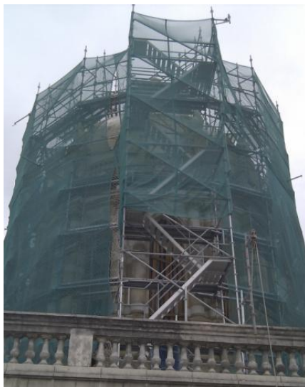
Figura 8 - Detalle de la restauración de la cúpula, con todo el sistema de andamiaje y protección.
