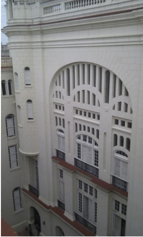
Fig.12- Fachada interior restaurada en 2005.
