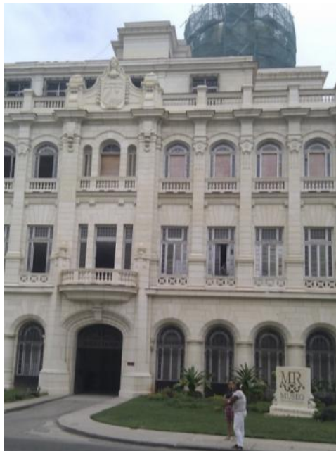
Figura 15- Fachada este restaurada en 2012.
