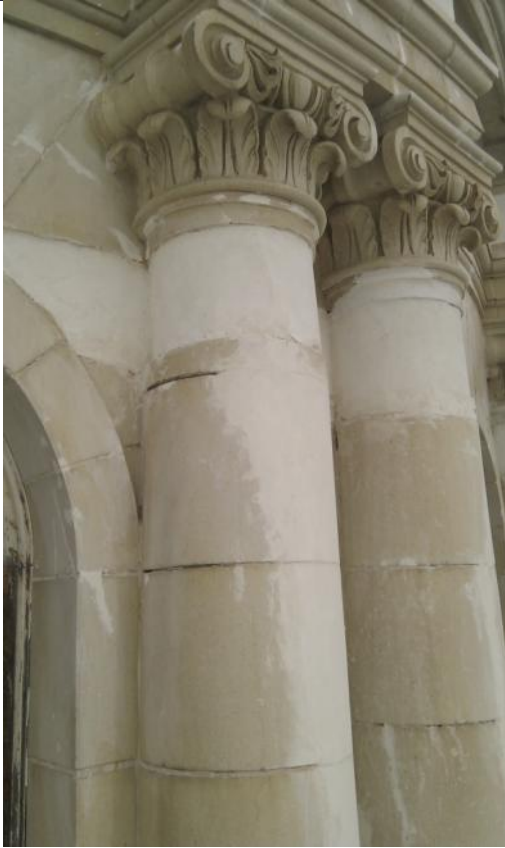
Figura 10 - Detalle del trabajo de restauración en las columnas donde se aplica tejido de fibra de vidrio con polvo de mármol y consolidante para fortalecer y conformar las capas estructurales decapadas por el alto nivel de deterioro.
