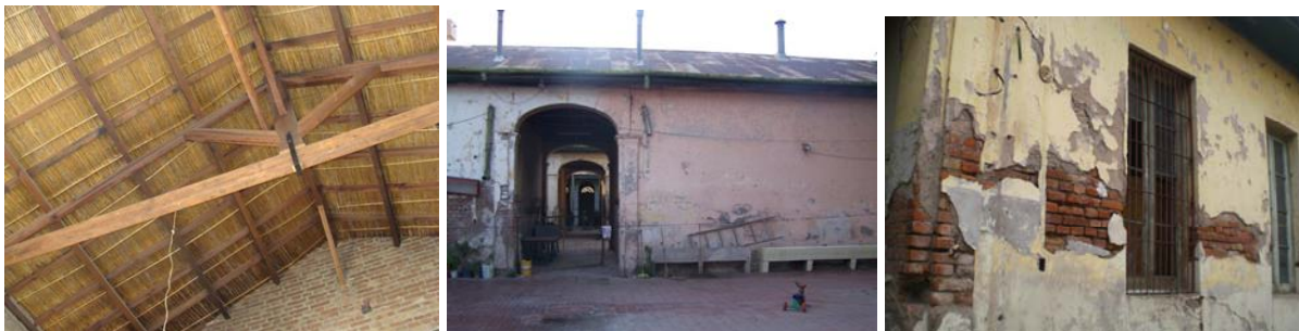
Figura 2 - Cubierta, vista posterior y estado de mampostería durante el relevamiento
