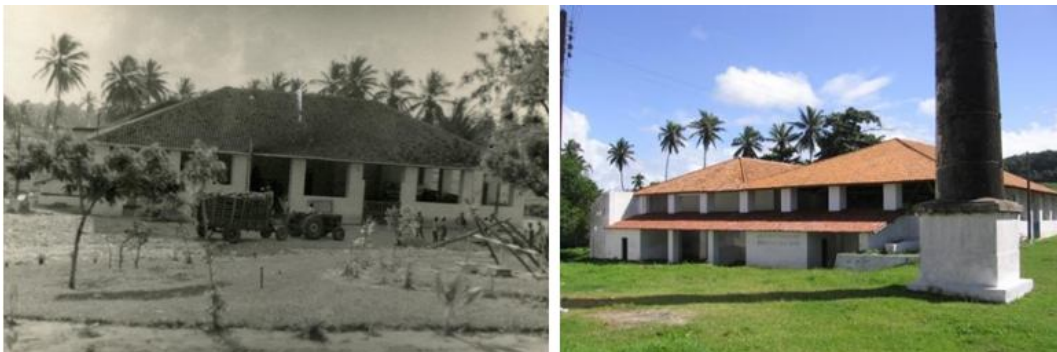
Figura 5: Fotografia antiga da moita e após recuperação em 2008. Fonte: Acervo da FUNDAJ e Fundarpe, respectivamente.
