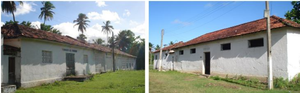
Figura 7: Casa de farinha e marcenaria. Na foto ao lado, padaria e subestação Fonte: Acervo Fundarpe
