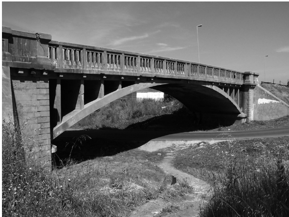
Imagen 2: Puente arco de hormigón armado. Gonnet, año 1916, diseño del Ing. Donato Gerardi.
