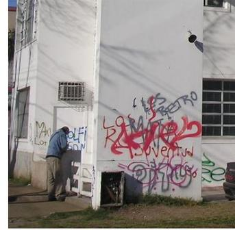
**Suciedad de paramentos ext, pintura graffitis, fisuramiento y pérdida de juntas en revestimiento Travertino**
