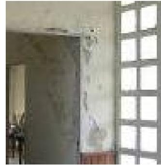
**Revoques interiores afectados por filtraciones: desprendimiento, ampollamiento, eflorescencias salitrosas**
