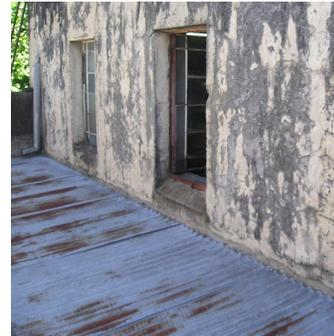
Reparaciones parciales, obsolescencia de cubiertas de chapa, desajustes de piezas componentes
