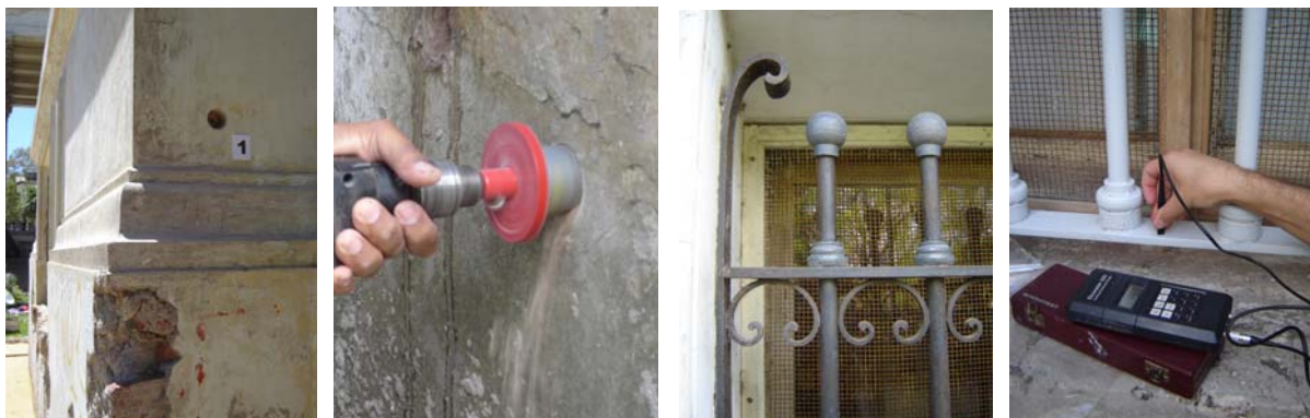
Fotografía 7y 8. Toma de muestras de revoques Fotografía 9 y 10. Limpieza de rejas y medición de pinturas
