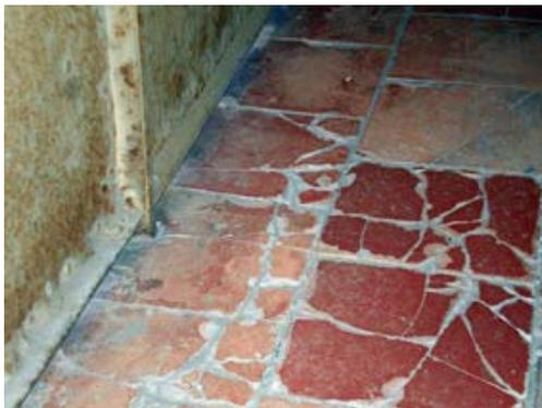
... en el segundo caso se analizará en laboratorio el material para encontrar la fabricación que coincida más a lo existente.
