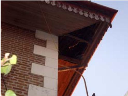
... como así se observó desprendimientos o faltantes en el cielorrasos exteriores bajo los aleros de los techados. Se restituirán con maderas de igual calidad o similar.
