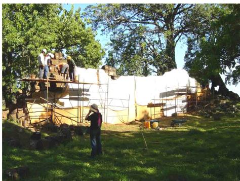
**Figura 20. Cobrimento dos maciços com pano umedecido, para cura gradativa da argamassa. Fonte: IPHAN, 2004.**
