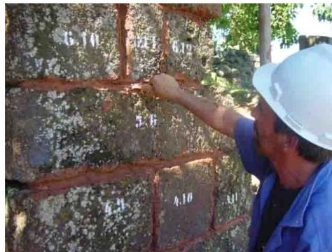
**Figura 17. Aplicação da argamassa. Fonte: IPHAN, 2004**
