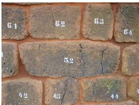
**Figura 19. Acabamento final das juntas. Fonte: IPHAN, 2004.**
