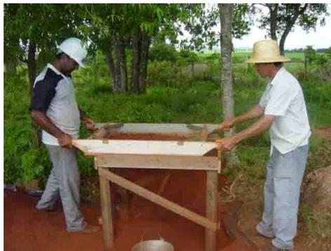
**Figura 15. Peneiramento da terra para argamassa. Fonte: IPHAN, 2004.**
