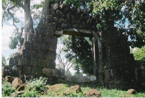
**Figura 04. Parede dupla com moldura de arenito e pedras em “cunha”, na face interna.**
