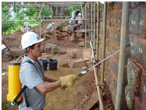
**Figura 21. Borrifamento de água para cura da argamassa. Fonte: IPHAN, 2004.**
