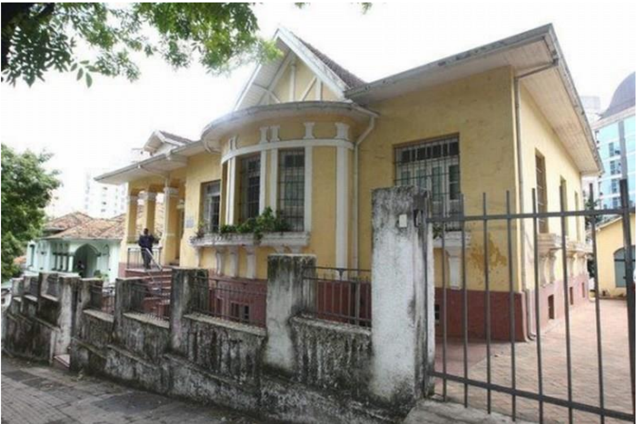
Figura 1 - Edificação que sedia o CRAV: fachada
