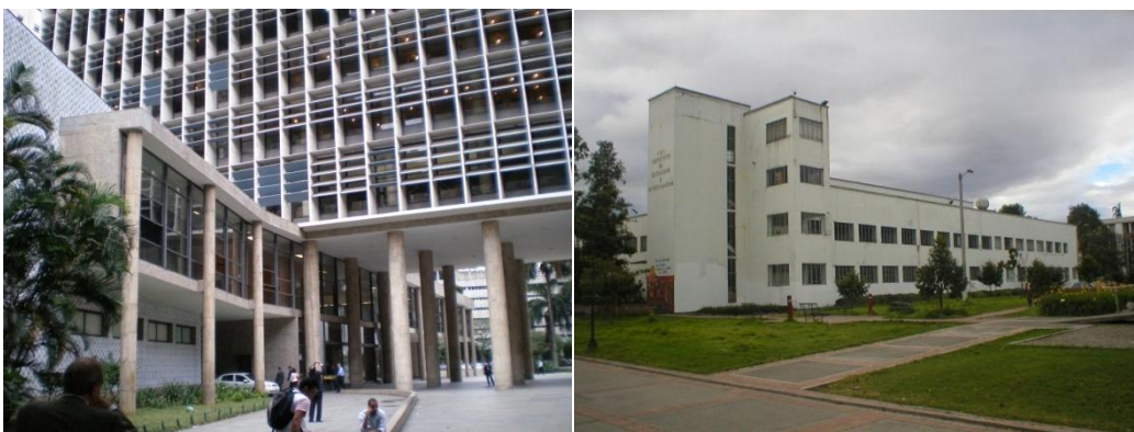
Palacio de la Cultura en Río de Janeiro y Campus Universitario en Bogotá (Fotos A. Conti)
