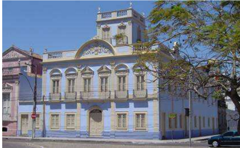
Figura 2 – Fachada atual do Casarão do Barão de Butuí. Fonte: Acervo autora, 2012.
