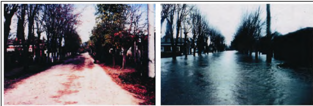
Fig. 41 - La misma calle, trazada sobre un antiguo cauce desviado, que se inunda ante una crecida.
