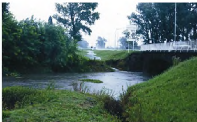
Fig. 42 – Camino Centenario - Puente sobre el Arroyo Rodríguez
