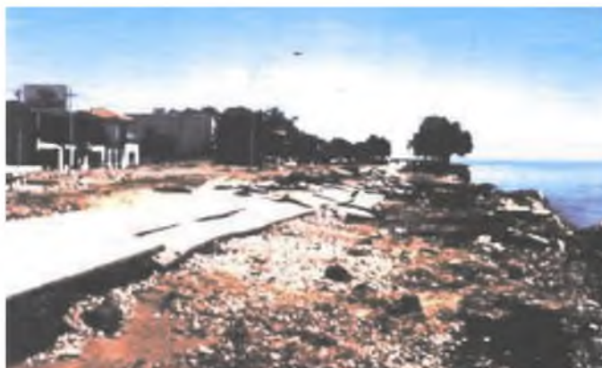
Figura 40 – Rotura del murallón de la costanera de Punta Lara
