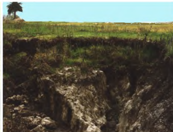
Fig. 29. Erosión en cárcavas en Natracualtes del Área de Origen Mixto - Unidad Geomórfica Antiguo Estuario Interior.
