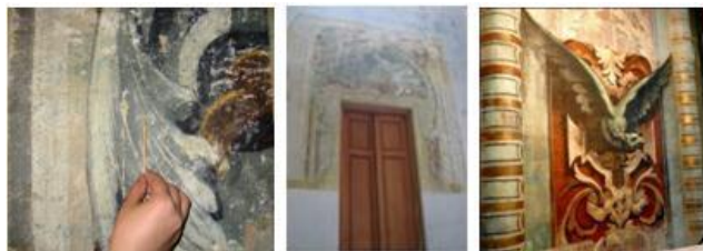
img. 16 Detalles de pintura mural en proceso de restauración. Dinteles y arco de boca, fuente bitácora de obra 2011.
