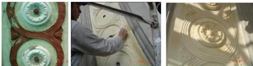
img. 14 Detalles de rosetas y lazos, estado de conservación en 2006 e integración de nuevos elementos en cemento fundido con técnica Ramelli.
