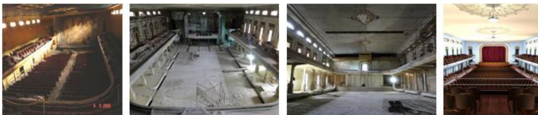
img. 8 La sala y el proceso de obra. Estado 2006, obra 2010 e imaginario a 2011. Fuente Bitácora de obra.
