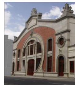
img. 11 La fachada restaurada. 2011. Fuente bitácora de obra.
