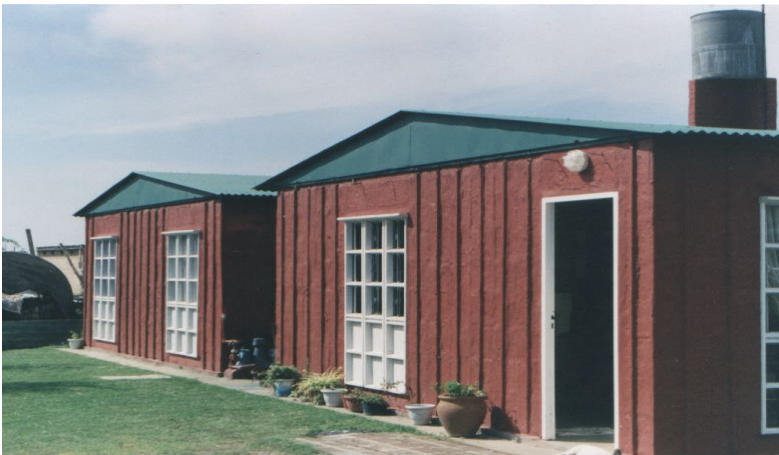
Fig. 4: Estructura en servicio evaluada
