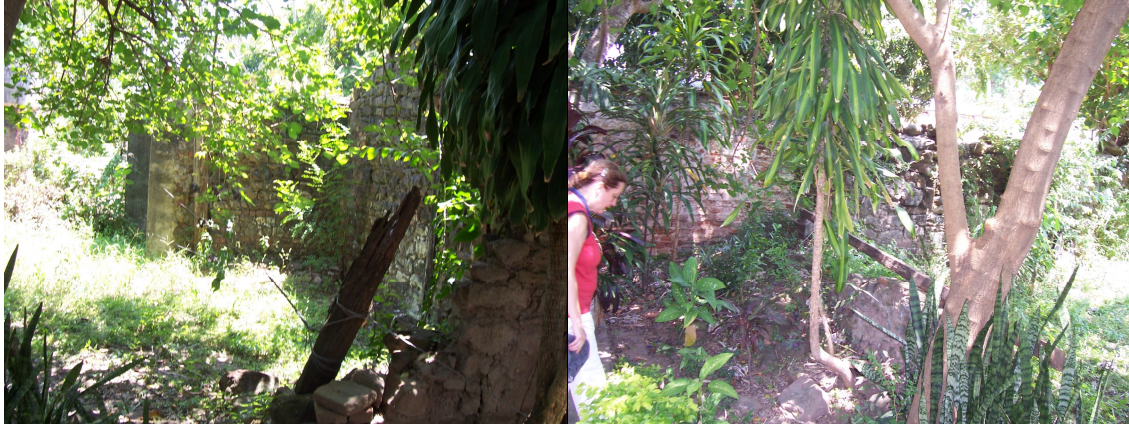
Vista del estado que presentaba la obra al momento de inicio de la restauración (Fotos A. S. N.)
