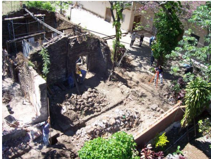
Vista General con el trabajo arqueológico iniciado y el Muro de Cierre medianero construido-(Foto A. Sánchez Negrette)
