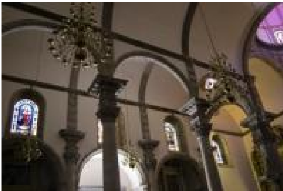
Fig 6.- Nave lateral y cimborrio
