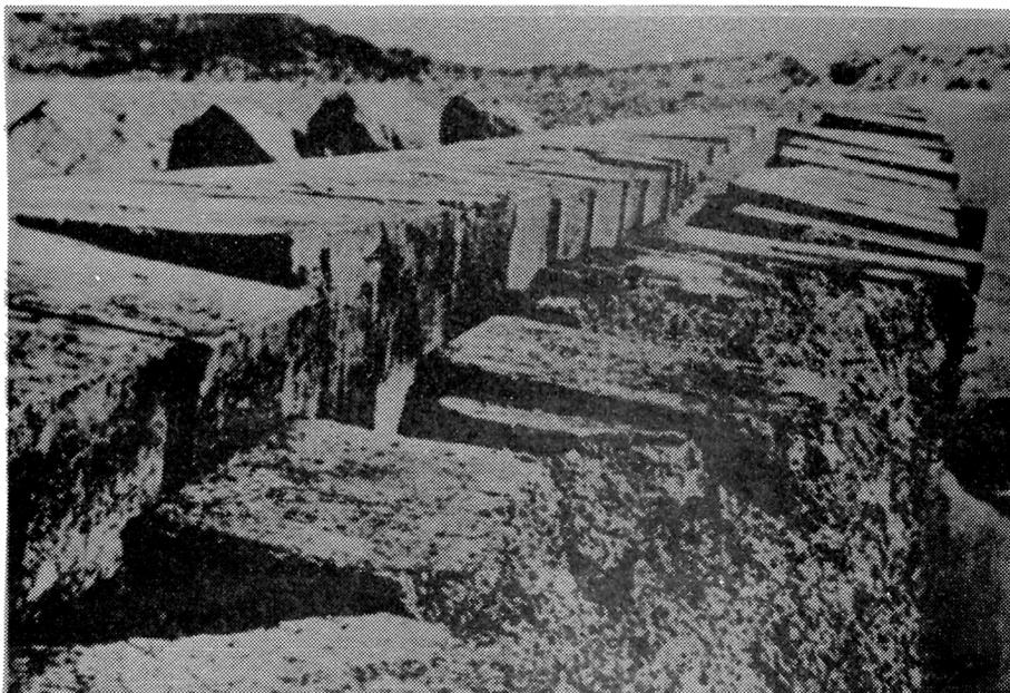
**Fig. 19.- Bloques de hormigón de cemento portland normal sometidos a la acción del agua de mar y dañados por una reacción árido-álcali (Imre Biczok, 2)**
