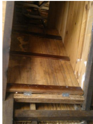
Figura 9 – Alçapão de acesso ao segundo pisos do forno de cal [26]
