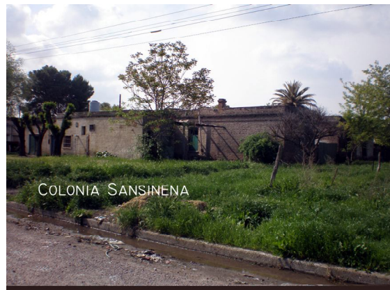
Foto 22: Vista desde Frigorífico
