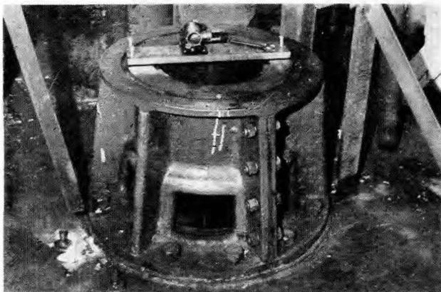
Fig. 11.—Vista del prisma y su montaje sobre el plano superior de uno de los cojinetes.
