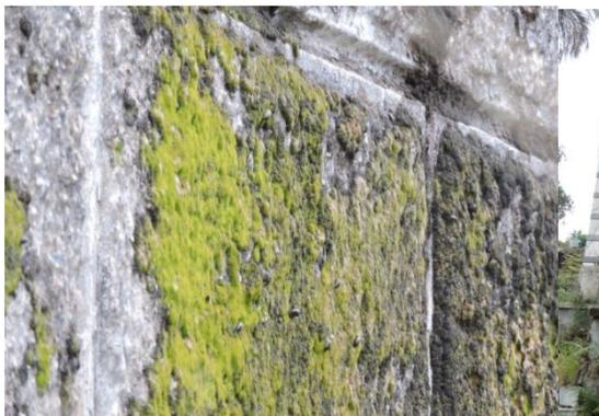
Figura 40 Muro cubierto por musgos
