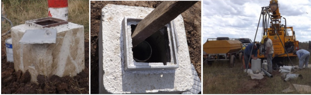
Figura 10: trabajo de campo para la construcción de los freáticos: primera etapa
