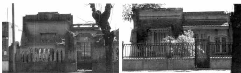
Casa de galería
