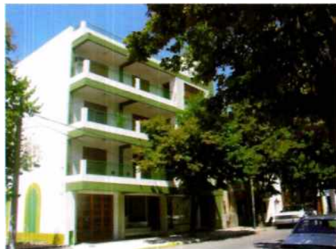
Edificio de 4 niveles
