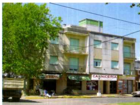
Edificio de 3 niveles
