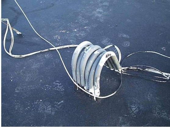
Foto 02 – Acervo do Autor - Exemplo de interface com projeto elétrico, onde uma laje impermeabilizada recebe prumada com eletrodutos, porém a NBR 9575/2003, indica de espaçamentos entre faces verticais (tubulação x tubulação ou tubulação x paredes), devem ter uma distancia mínima de 10 cm possibilitando o arremate impermeabilizante entre os mesmos.
