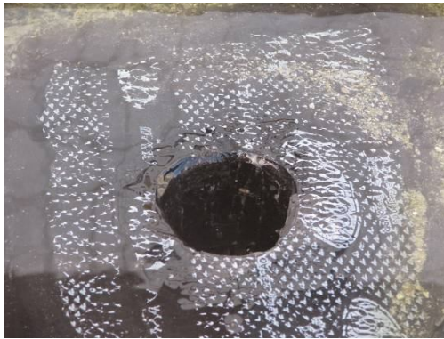
Foto 02 – Acervo do Autor - Exemplo de interface com projeto elétrico, onde uma laje impermeabilizada recebe prumada com eletrodutos, porém a NBR 9575/2003, indica de espaçamentos entre faces verticais (tubulação x tubulação ou tubulação x paredes), devem ter uma distancia mínima de 10 cm possibilitando o arremate impermeabilizante entre os mesmos.
