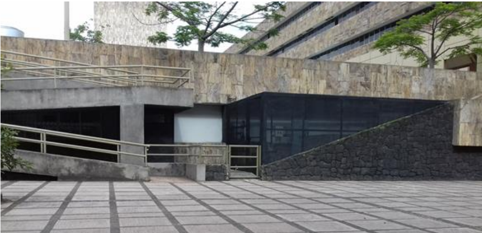
Figura 65. Exposición solar en la pared oeste de la edificación (14:50 horas).
