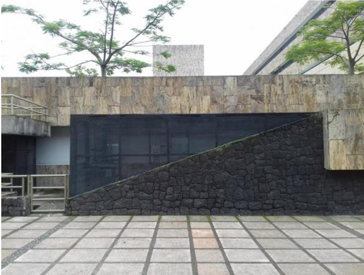
Figura 59. Casa de máquinas del sistema actual.
