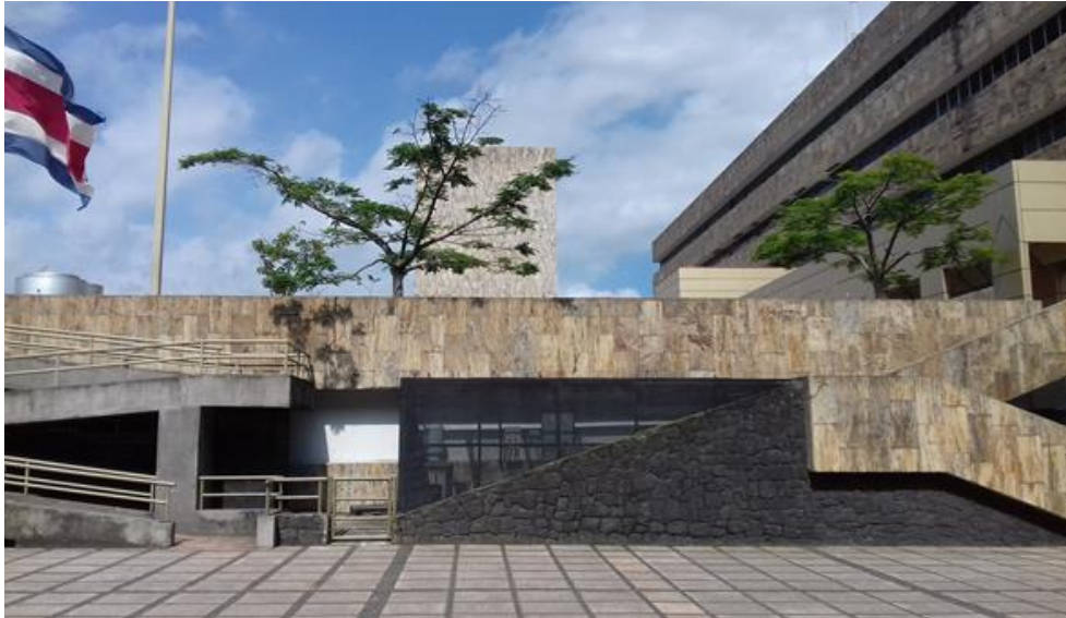
Figura 62. Exposición solar en la pared oeste de la edificación (14:20 horas).
