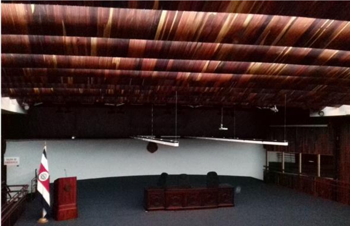
Figura 32. Cielorraso del auditorio.
