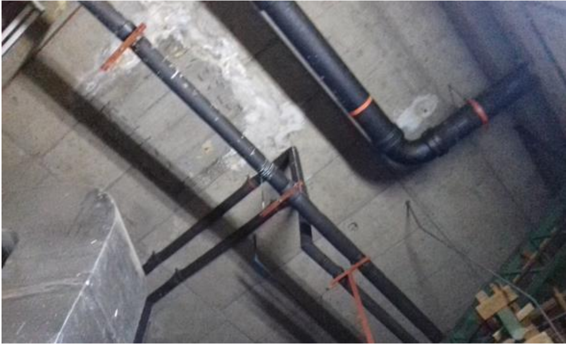
Figura 28. Techo de la estructura.
