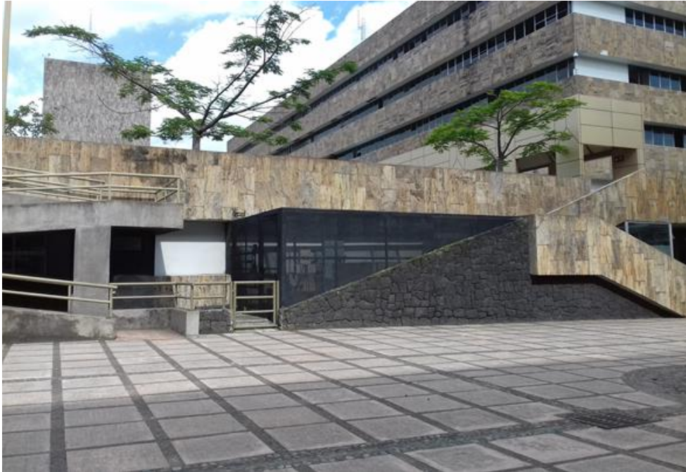
Figura 64. Exposición solar en la pared oeste de la edificación (14:40 horas).
