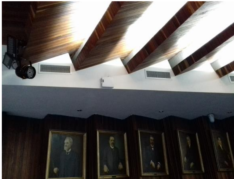
Figura 47. Patrón del cielo raso con luz indirecta.
