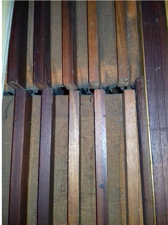
Figura 45. Abertura en pared de madera.
