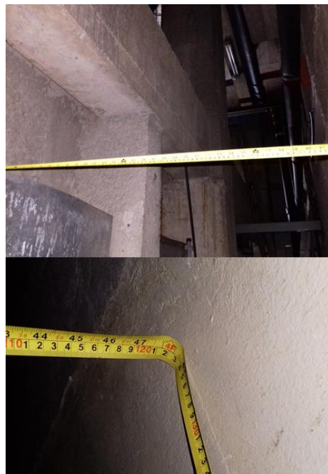
Figura 58. Distancia entre la pared norte y la estructura de la edificación.
