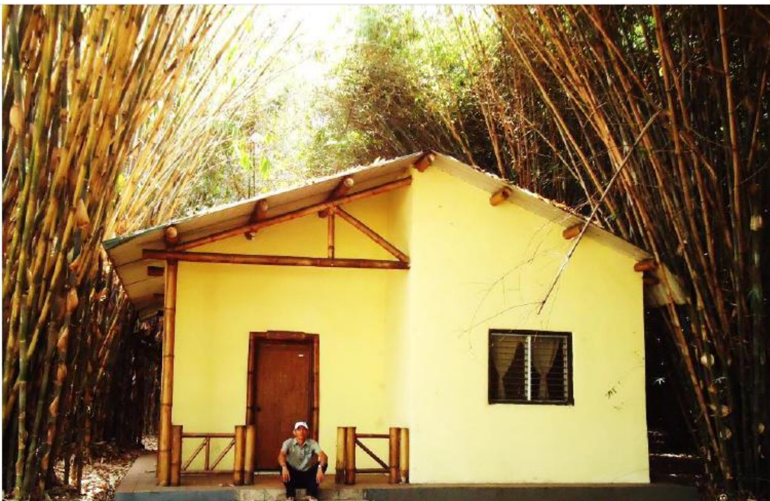
Vivienda social de bambú y cemento – Guatemala 2013
