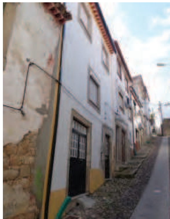
Fig 4. - Tipologia do edificado
