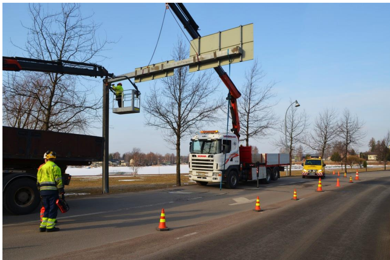
Kuva 7. Portaalin väliaikainen irrottaminen erikoiskuljetuksen tieltä (kuva: Esa Penttinen).
