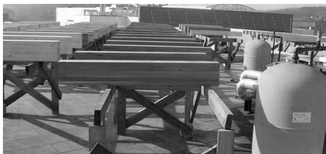
Figura 31: Colocação das vigas para envelhecimento natural (Gaspar 2010).
