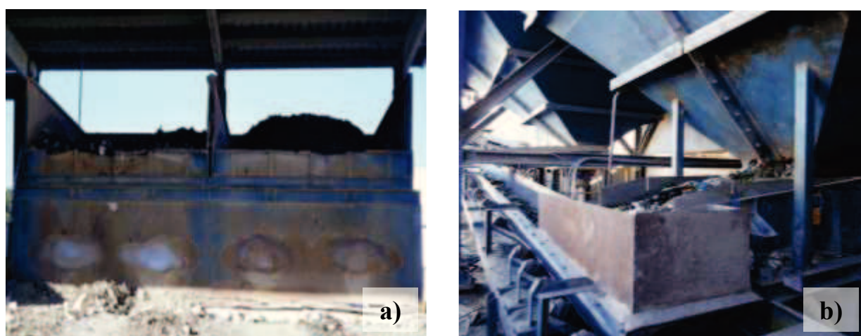
Figura 15: Silos: a) Parte frontal dos silos; b) Parte traseira dos silos.
