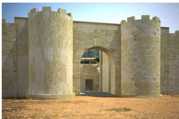
Figura 16. Vista general de la puerta sur a comienzos del s. III d.C., con el adosamiento de las torres exteriores semicirculares.
