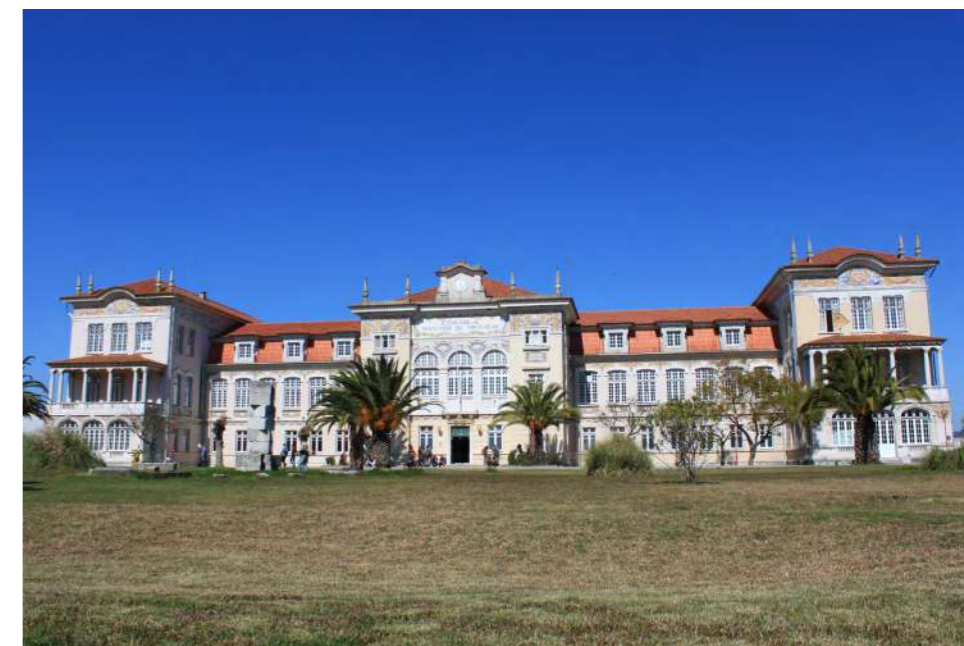
Figura 9. Perspetiva da fachada principal do edifício da Escola Normal de Lisboa. Fonte: Escola Superior de Educação de Lisboa
