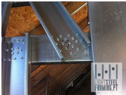
Figura 3- Pormenor dos sistemas de fixação mecânicos utilizados na construção em aço leve [3].
