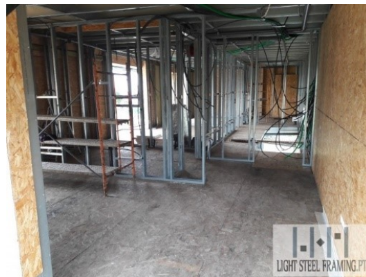
Figura 4- Colocação de rede de tubagens [3].
