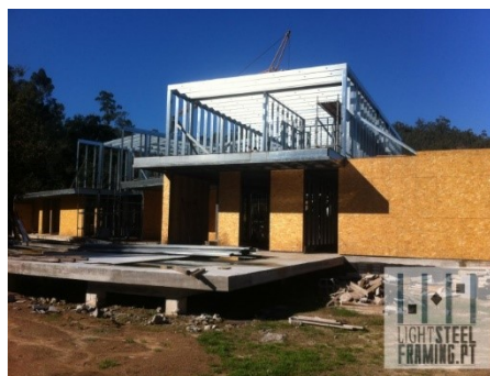
Figura 2- Moradia construída em aço enformado a frio [3].
