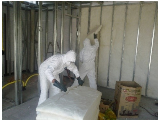
Figura 5- Aplicação do isolamento térmico e acústico [5].
