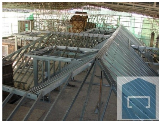
Figura 8- Utilização de elementos de aço leve na construção de coberturas [3].
