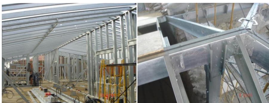
Figura 3 - Vista interior da estrutura metálica com travessas inclinadas e pormenor do nó de ligação de cobertura, [2].
