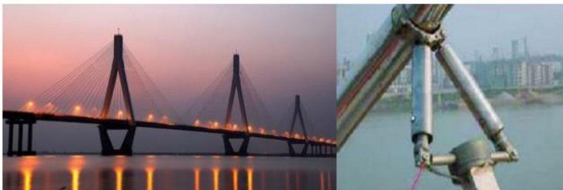
Figura 22 - Ponte atirantada sobre o lago Dongting e pormenor de um actuador colocado nos tirantes (Crivellaro, 2008).
