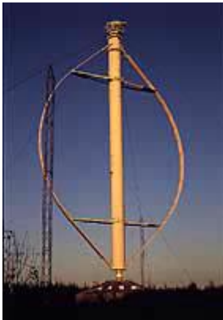
Figura 2.19: Aerogerador de eixo vertical do tipo Darrieus [Rui M.G.Castro, 2005].
