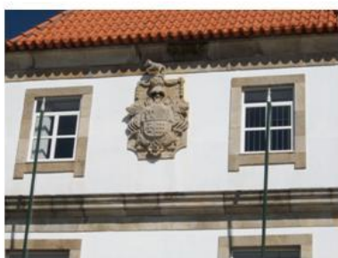
Edifício da Câmara
