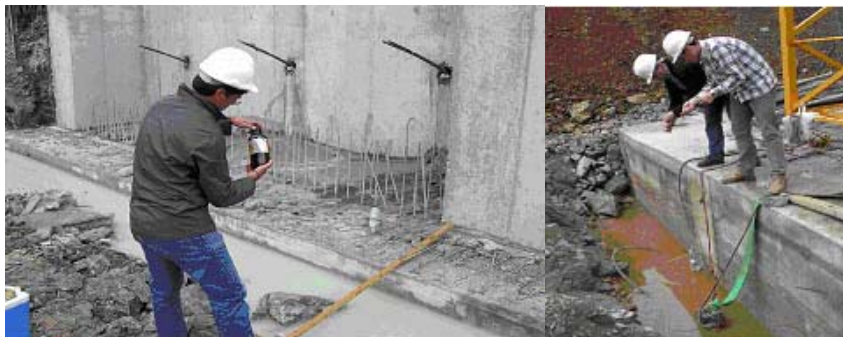
Figura 4 – Recolha de efluentes de obra
