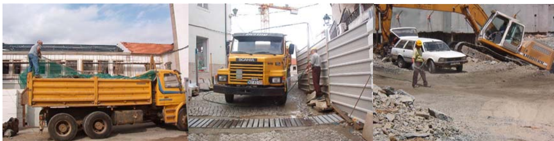
Figura 5: Lavagem dos Rodados, humedecimento da superfície da obra e cobertura das cargas.
