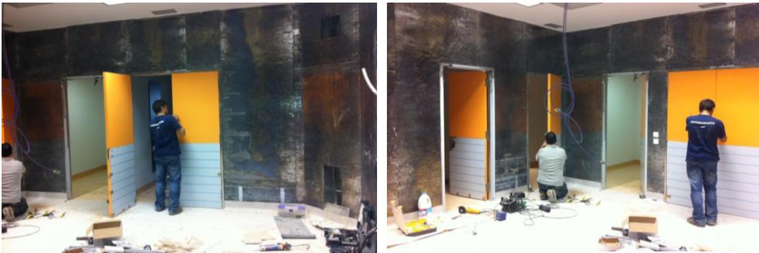
Figura 7.6 – Colocação de portas com chumbo na sala de Pacemaker.
