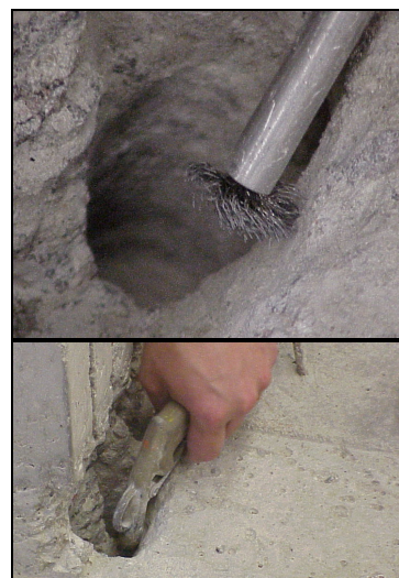
Figura 5 - Limpeza dos buracos de fixação dos laminados à sapata.
