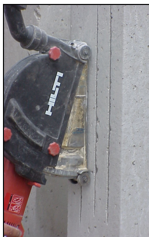
Figura 3 - Abertura das ranhuras.
