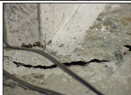
Figura 19 – Deficiências no reforço do pilar P16bCR .
