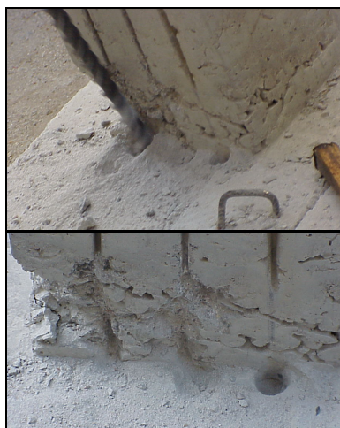
Figura 4 - Abertura dos buracos de fixação dos laminados à sapata.
