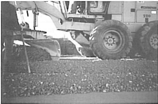
e) espalhamento da 2ª camada de solo
