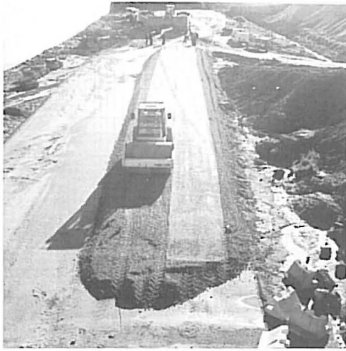
c) compactação da 1ª camada
