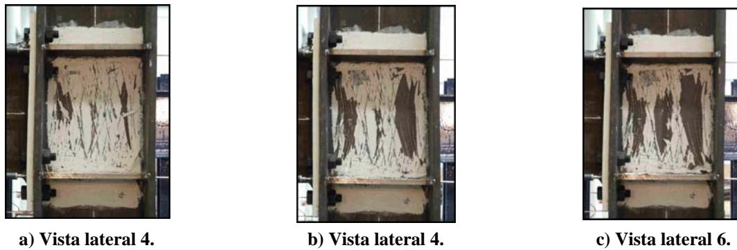
Figura 3-166 – Deformação progressiva do painel da alma do pilar.
