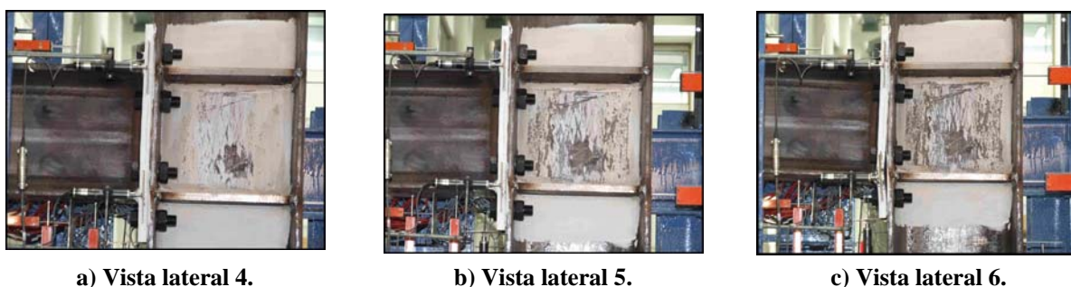
Figura 3-172 – Deformação progressiva do painel da alma do pilar.
