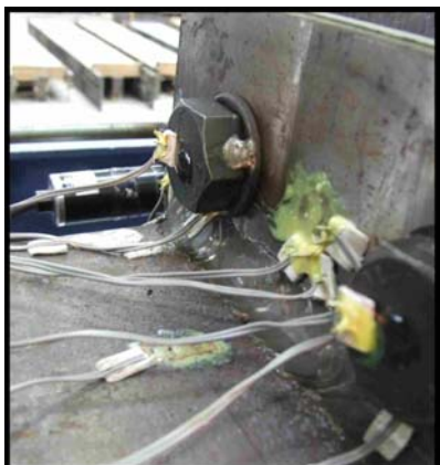
Figura 3-69 – Pormenor do início da rotura da ligação J1.3
