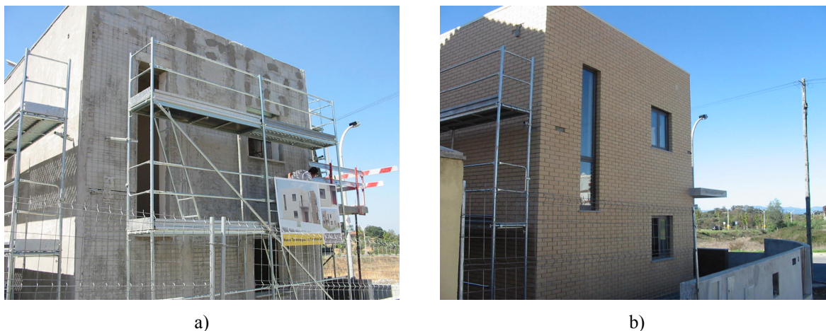
Figura 17: Edifício de habitação unifamiliar SISMO: a) fase construtiva; b) Acabamento final.
