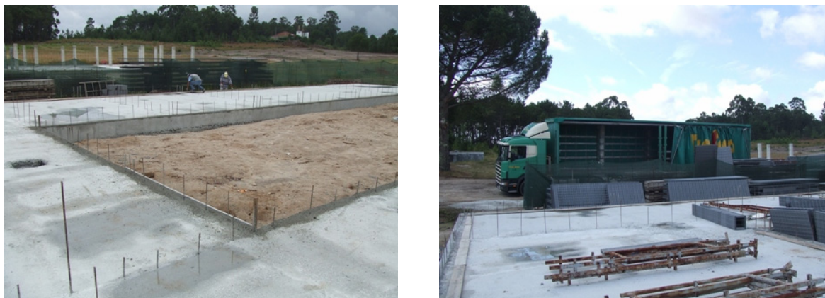
Figura 9: Fundações e preparação da laje de fundação. Transporte dos módulos.
