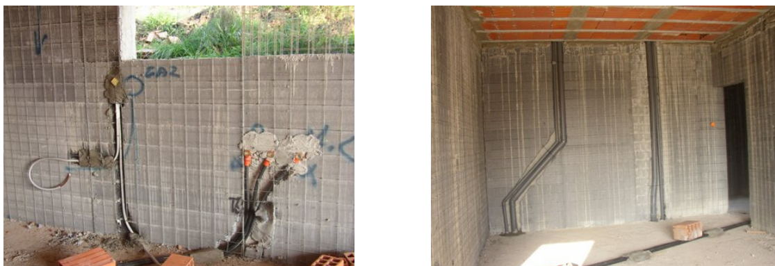
Figura 5: Negativos para tubagens nas paredes.
