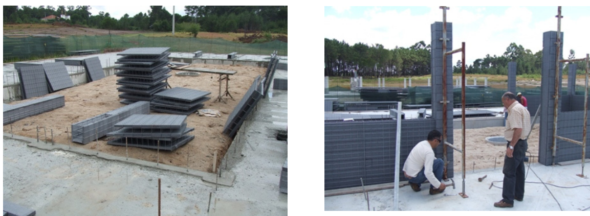
Figura 10: Aplicação dos módulos SISMO numa habitação unifamiliar.
