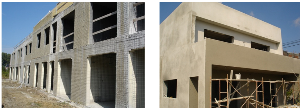
Figura 16: Pormenor do alçado (acabado) e aspecto final antes da aplicação do acabamento.
