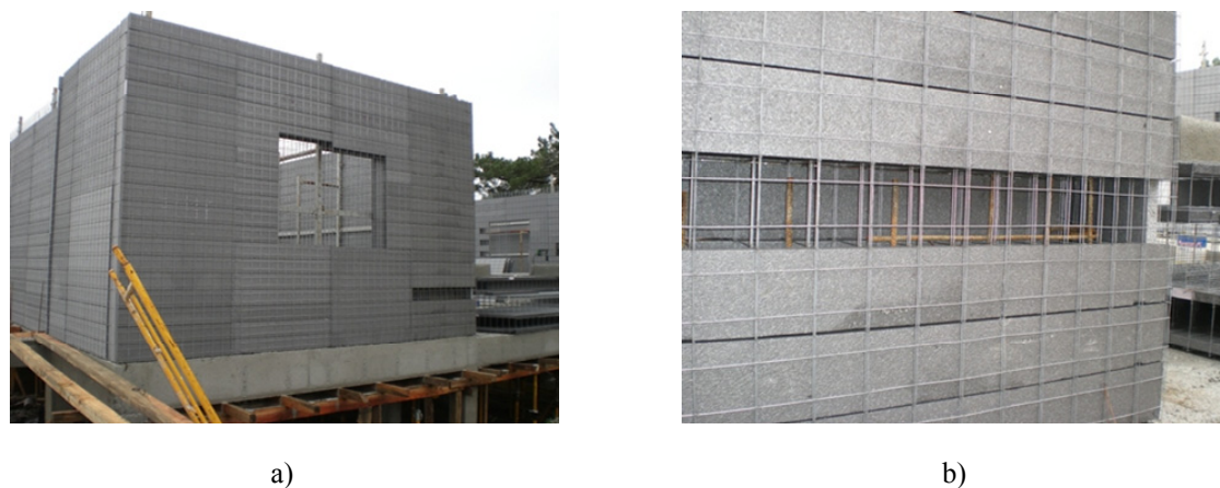
Figura 6: Paredes SISMO: a) Negativos para janelas; b) Armaduras do enchimento interior.
