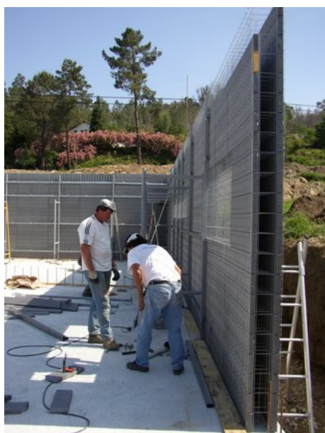
Figura 15: Pormenor da construção das paredes e negativo para a janela.
