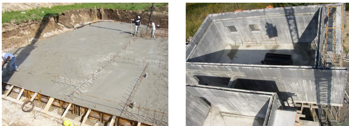
Figura 12: Laje de fundação e perspectiva do piso.
