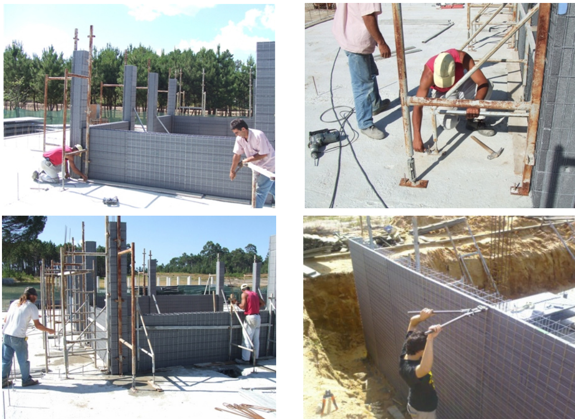
Figura 11: Aplicação dos módulos SISMO numa habitação unifamiliar.
