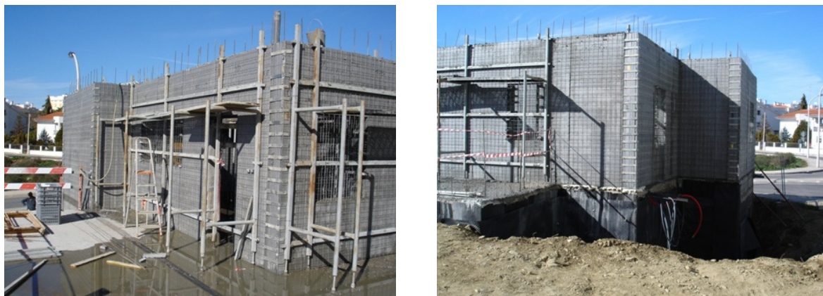
Figura 8: Ligações monolíticas entre elementos e pormenores construtivos.
