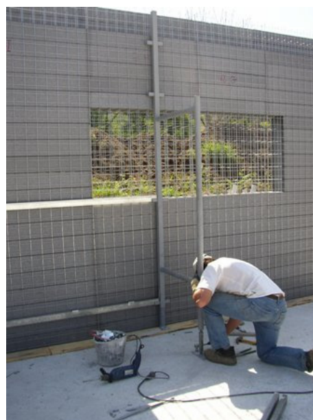
Figura 15: Pormenor da construção das paredes e negativo para a janela.
