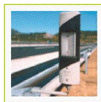
Figura 16: Exemplo de retrorreflector do tipo delineador (imagem retirada do sítio Web da BRISA — Auto-estradas de Portugal).
