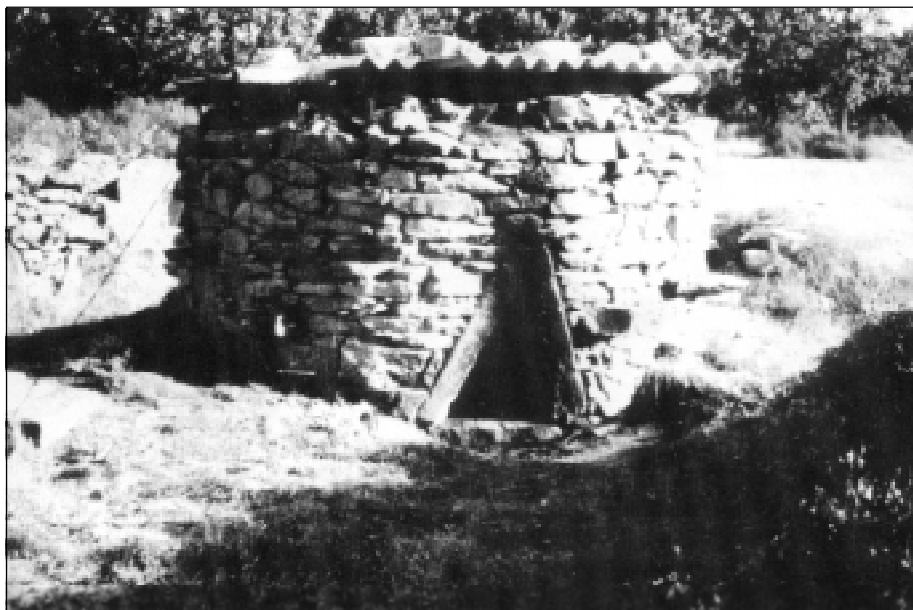
Figura 80 - Forno cilíndrico de tiragem vertical ainda hoje em utilização em Moveros, Alcañices, Zamora.
