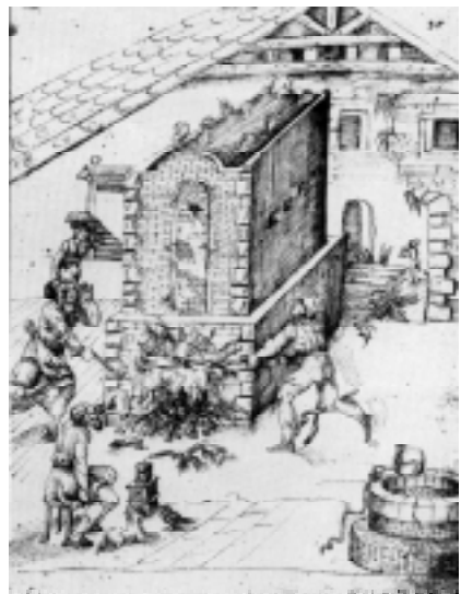
Figura 1 - Gravura do Tratado de Cerâmica de Piccolpasso (século XVI), representando um forno no Renascimento. Enquanto que os fogueiros alimentam o fogo, o homem sentado, provavelmente o chefe, consulta o relógio de areia.
