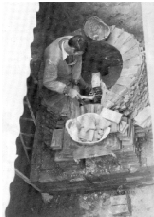
Figura 158 - Construção de forno cilíndrico a lenha.
