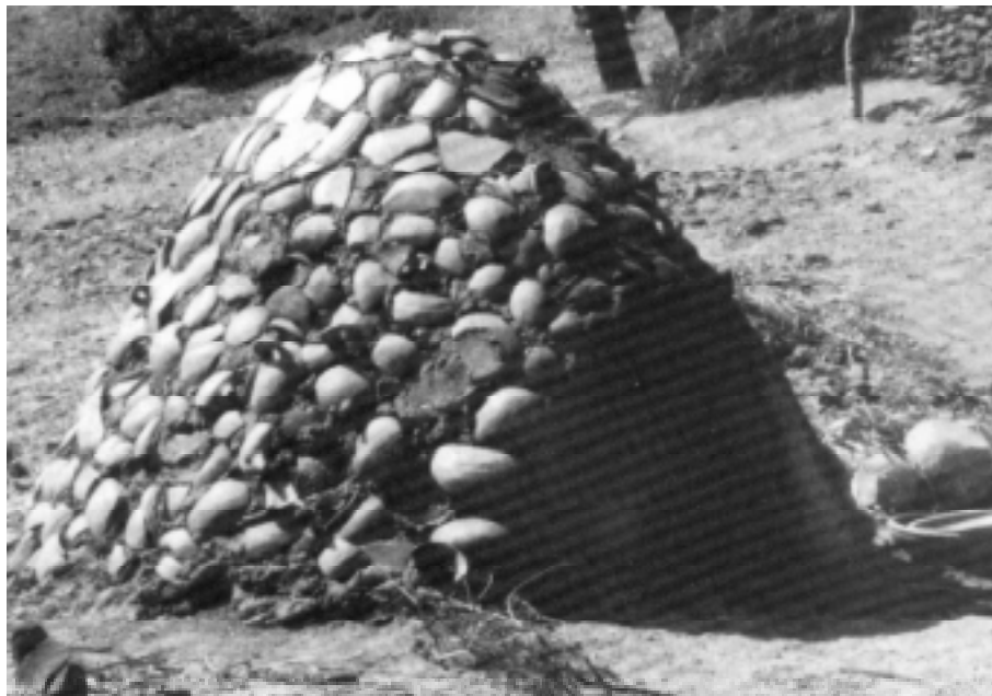
Figura 103 - Forno primitivo construído com paredes de barro e restos de peças partidas em Ifrane Ali, Marrocos 1 .
