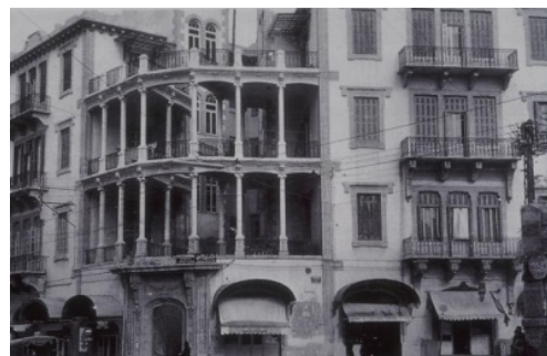
Fig. 28a: Barakat building, immagine storica
