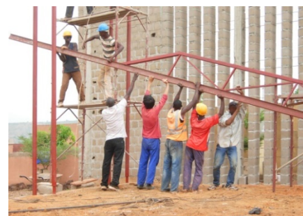
Fig. 21 f: Montaggio struttura di ferro
