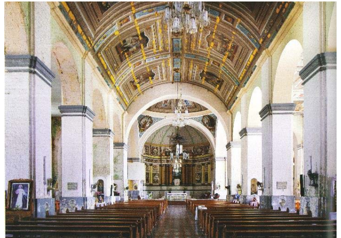
Fig. 53 b: Vista interna
