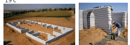
Fig. 19 e, f: Fondazioni e mura perimetrali realizzati con la tecnica earth-bags
