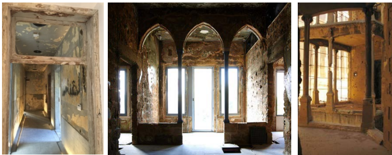
Fig. 28 r, s, t: Barakat building: vista sale della memoria
