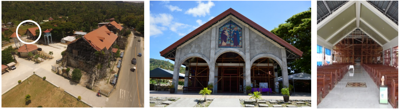
Fig. 43a:Loboc, Vista dall'alto dopo il terremoto (Google earth); Fig. 43 b, c: Chiesa provvisoria, vista esterna (A. Mustilli, 2016) e vista interna (2015)
