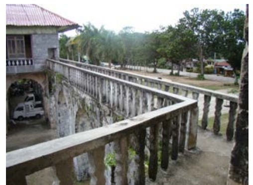
Fig. 71 Albuquerque: Vista dalla Chiesa al convento
