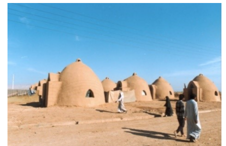
Fig. 17: 1994 Campo dei rifugiati di Baninajar in Khuzestan (Iran) Realizzazione con autoconstruzione da un gruppo di 6 rifugiati, supervisionati dal personale UNHCR, in 7/11 giorni al costo di $625.
