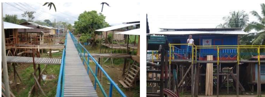
Fig. 12 a, b, c Napipi: costruzione del ponte di collegamento; ambulatorio, abitazione
