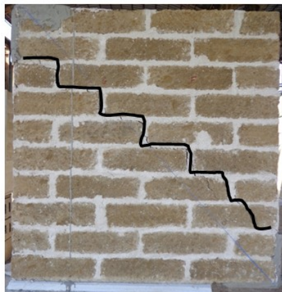
Figura 3.18 Quadro fessurativo del pannello non rinforzato
