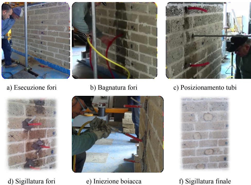
Figura 2.29 Fasi esecutive intervento di rinforzo con connessioni in composito
