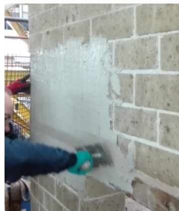
Stesura del primo strato (6 mm) di malta per l'applicazione della rete
