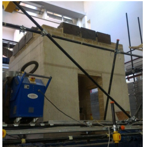
Figura 5.30 Fase 4: Realizzazione intonaco esterno e interno con malta di calce fibrorinforzata (spessore medio 1,5 cm)
