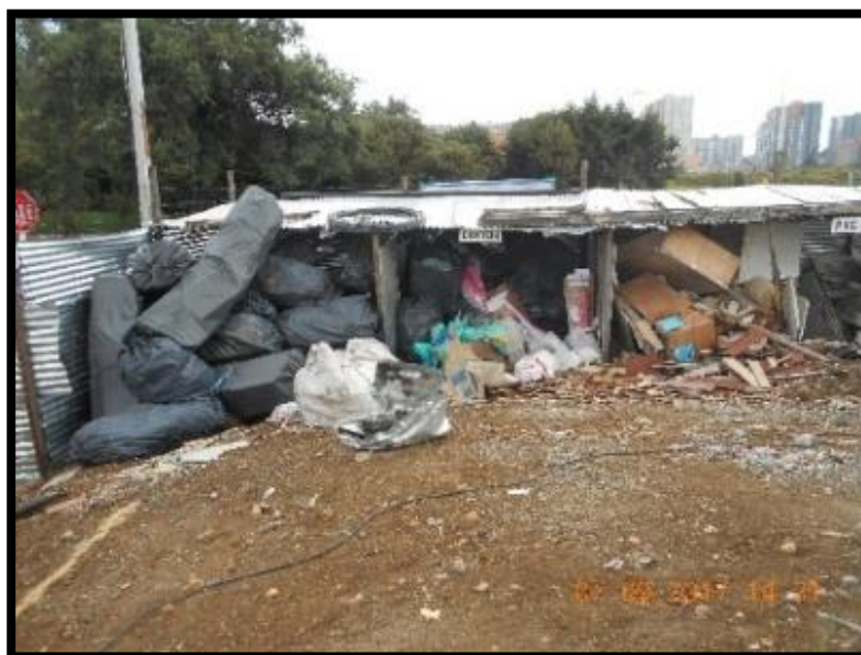
Punto de acopio de obra de construcción ubicada en hayuelos- Visita Obra
