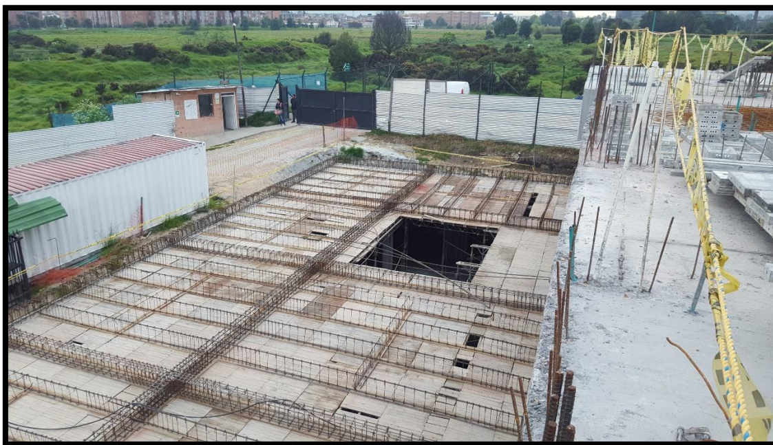
Placa de transición- visita a obra
