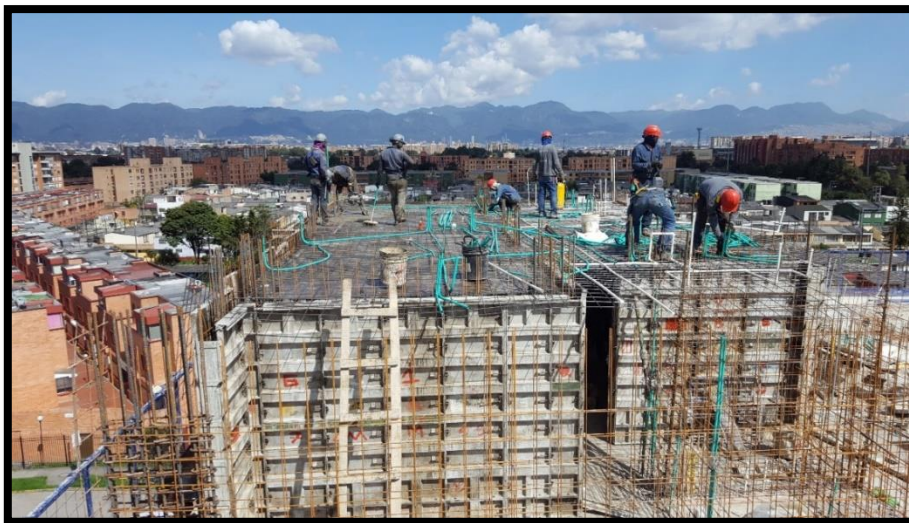
Sistema constructivo Forsa- Visita a Obra.
