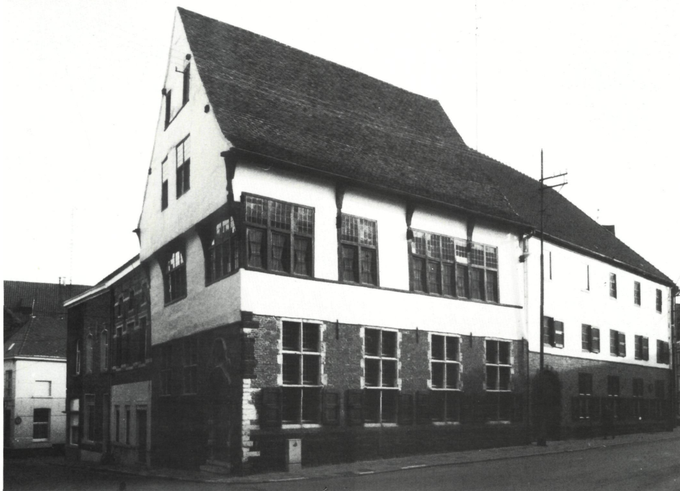
'De Roskam', 15de-16de eeuw. De bovenverdieping is opgetrokken in leem en hout, de zogenaamde vakwerkbouw.
