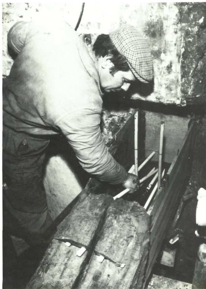
Het injecteren van de mortelspecie (foto verz. SAS, Gent).
