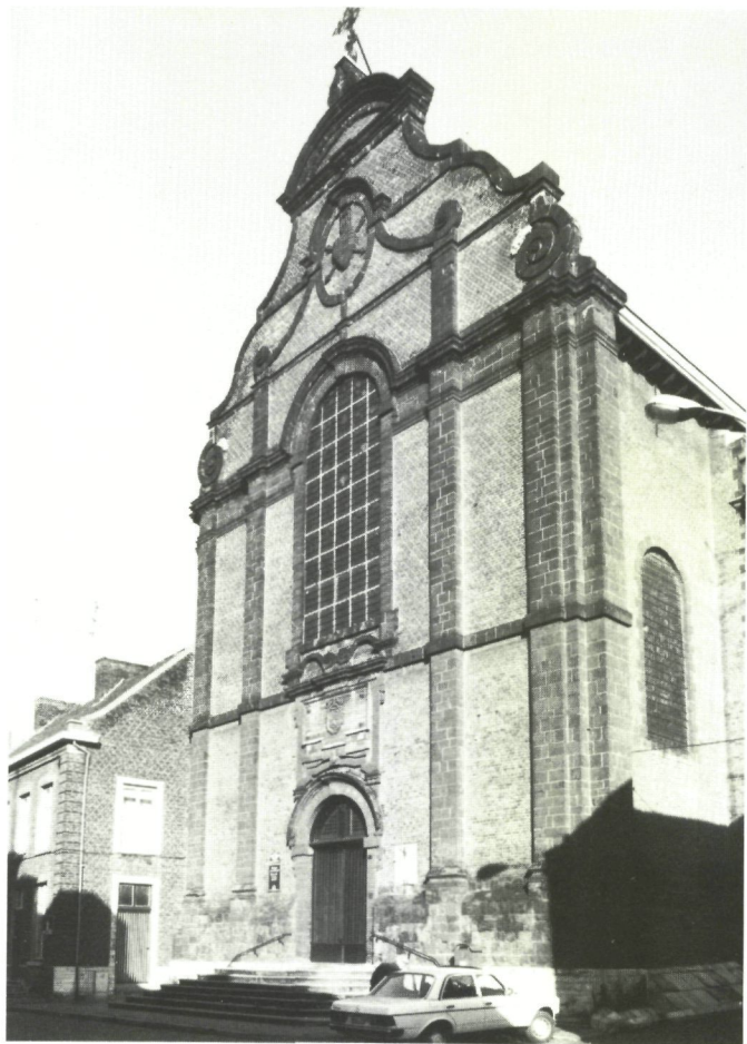
De St.-Barbarakerk (1656 e.v.), bediend door de paters Kruisheren en gebouwd in een mengeling van baksteen en plaatselijke ijzerzandsteen.
